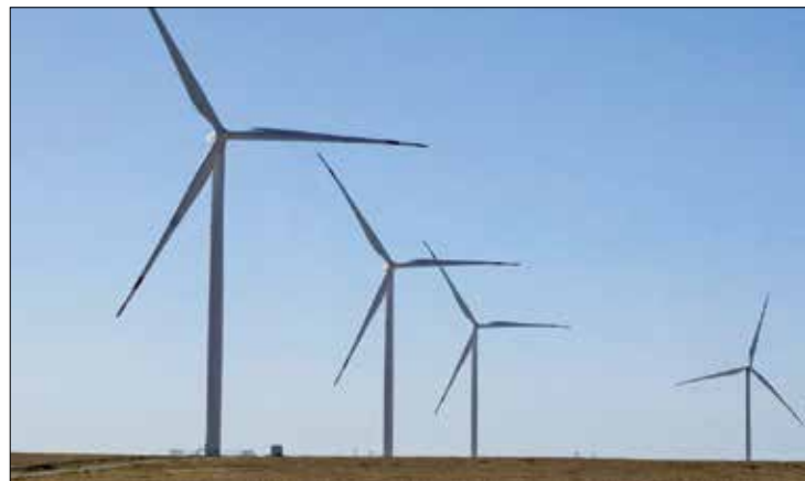
这是哈萨克斯坦扎纳塔斯风电场风机。扎纳塔斯100兆瓦风电项目是中哈合作的中亚最大风电项目。
