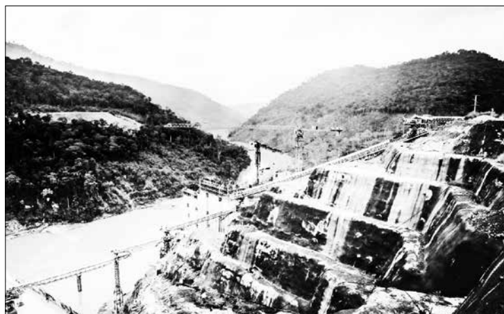
Строителна площадка на хидроенергийния проект „Нам Теун 1“ в Лаос
